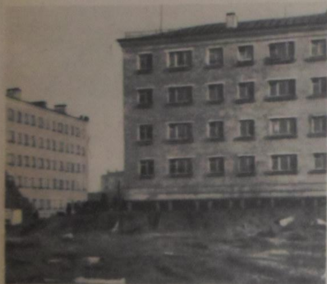
Рис. 107. Дома на многолетней мерзлоте (под домом видны бетонные сваи).
